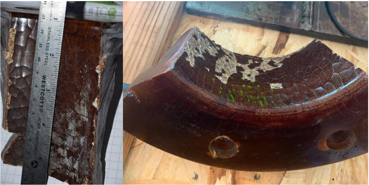
图4. FRP的内表面状况和腐蚀
